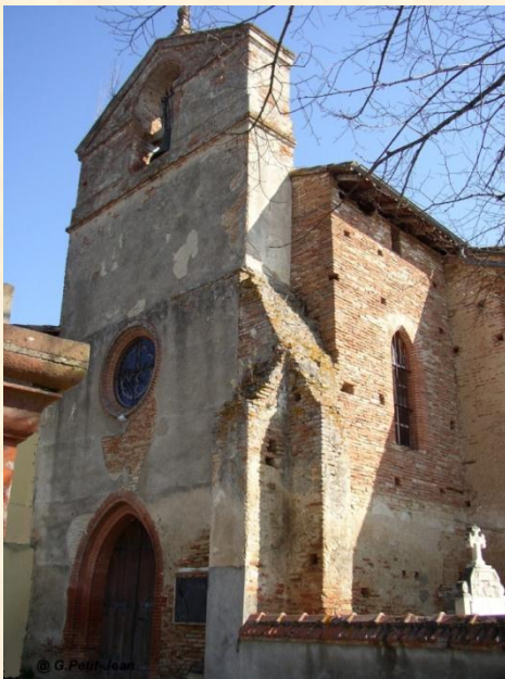
Eglise de Piquecos (G. P-J)
